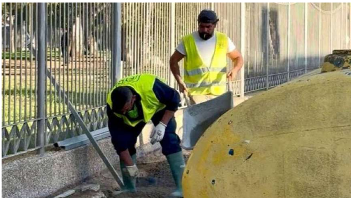
Una imagen de las obras que se acometen en la avenida de Cádiz.
